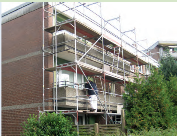
Wildacker/Schnelsener Weg, Balkonsanierung
