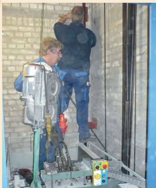
Schnelsener Weg: barrierefreie Umrüstung der Aufzugsanlage
