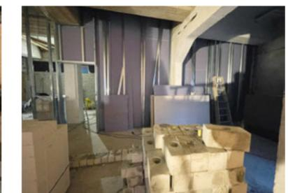
+++ WILDACKER 47: DACH GEDÄMMT +++ WENDELTRASSE AUSGEBAUT, BETONIERT, GESCHLOSSEN +++ WÄNDE ZWISCHEN KÜNFTIGEM NACHBARSCHAFTSTREFF UND GÄSTEWOHNUNGEN GEMAUERT +++ ELEKTRO-/SANITÄR-INSTALLATION FOLGT +++
