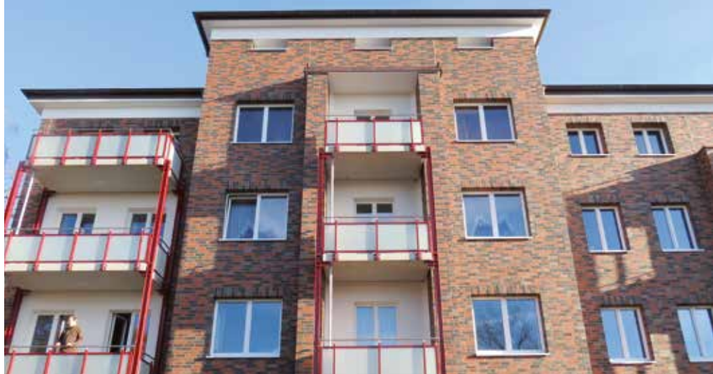
VE 28 Neue Fassaden und Balkone im Justus-Strandes-Weg
