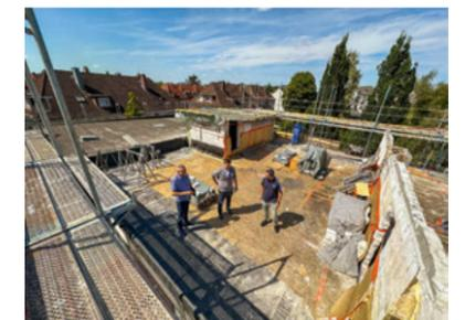
**+++ BAUSTELLE EINGERICHTET +++ GERÜST AUFGESTELLT +++ DACHBODEN ENTRÜMPELT +++ DACHGESCHOSS: INNENLIEGENDE WÄNDE ENTFERNT +++ ARBEITEN IM AUGUST: ABRUCH DER AUSSENWÄNDE IM 3. OG UND ABRUCH DACH**
