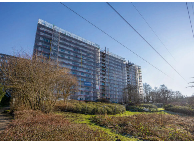
Bengelsdorfstraße 12-16 mit neuem Dach, gedämmter Fassade und neuen Fenstern.
